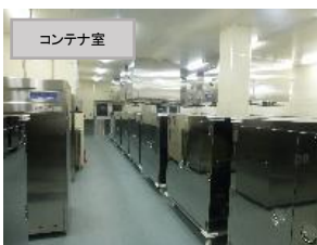
洗いあがった食器や食缶は、それぞれ専用の消毒保管装置で熱風消毒され保管されます
