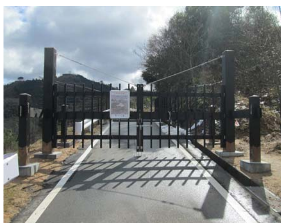
山城の郷付近の林道に設置している管理用の「門扉」
