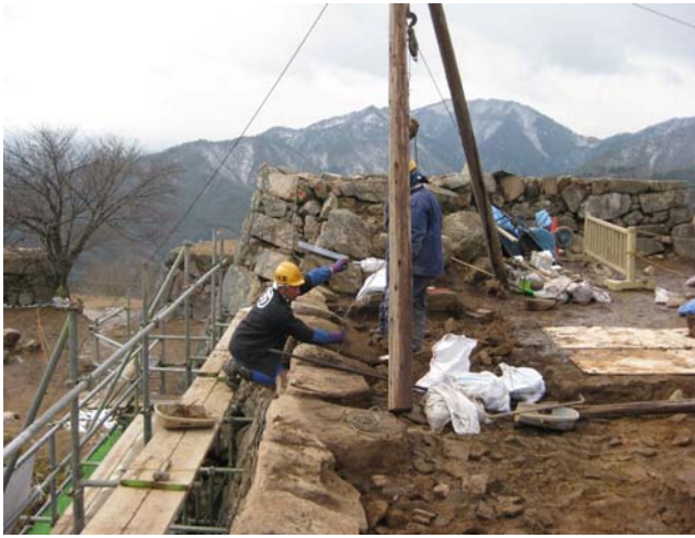
城内の石垣修復工事
