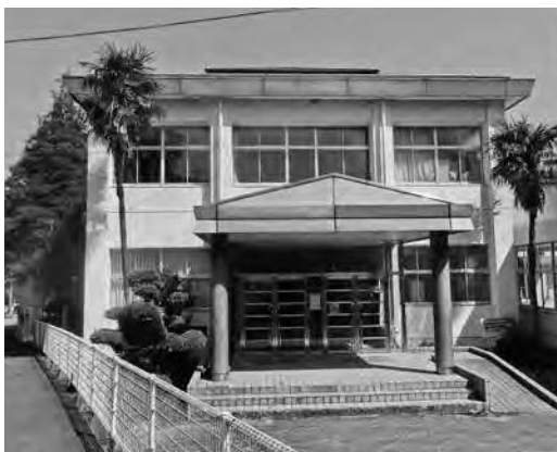
▲改修される山口小学校体育館
