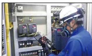
現場点検・パトロール中です。
