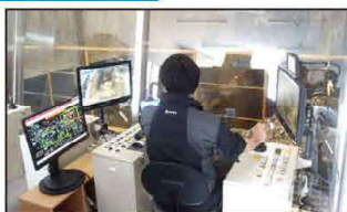
クレーンでゴミを攪拌・移動しています
