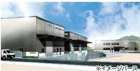
朝来市内に新社屋建設中!! 今年完成予定
