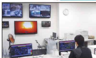
中央制御室でモニター監視中です
