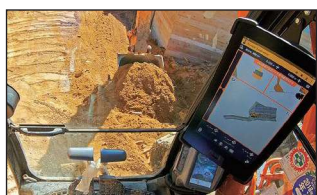
マシンガイダンスによる掘削
