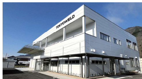
「朝来新社屋が完成しました!」
