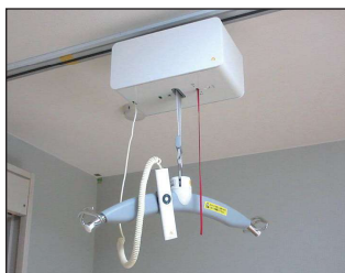
腰痛予防のためリフトを設置
