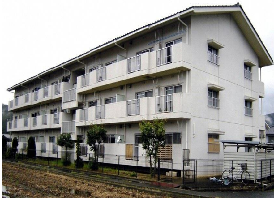
宮ノ下住宅 外観
