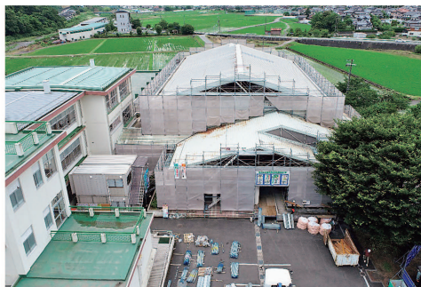
屋内運動場大規模改造（糸井小学校）
