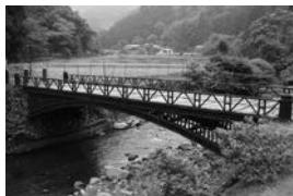
明治 18 年（1885）から 2 年間にわたる工事によって生野鉱山と神子畠鉱山を結ぶために神子畠川に架けられたもの。現存する鉄橋の中では日本で 3 番目に古く、全鋳鉄橋としては日本最古を誇ります。下から見上げるとフランスのエッフェル塔の骨組みに似ています。
