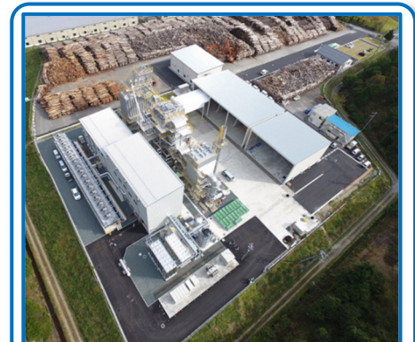
▲：木質バイオマス発電所
