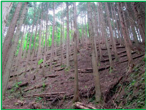
▲：朝来市内における間伐木を利用した土留工
