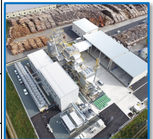
▲：木質バイオマス発電所
