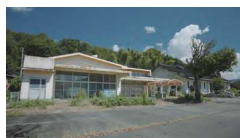
寺内養殖場 廃業した寺内幼稚園を改築し 養殖場として利用
