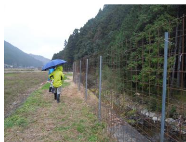
防護柵の設置状況
