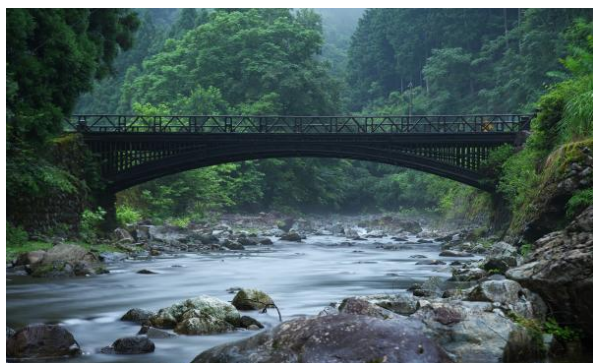
神子畑鑄鉄橋 （国指定文化財：建造物）
