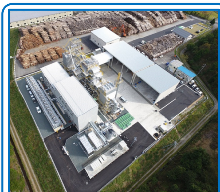
▲：木質バイオマス発電所
