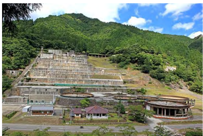
神子畑選鉱所跡とムーセ旧居（手前の洋館）
