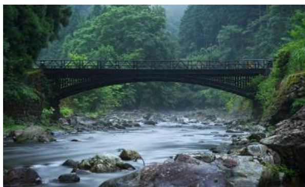
神子畑鑄鉄橋 （国指定文化財：建造物）
