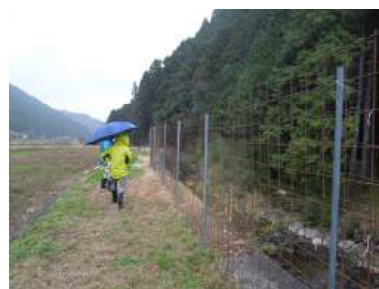
防護柵の設置状況
