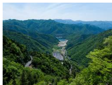
奥多々良木発電所のダム
