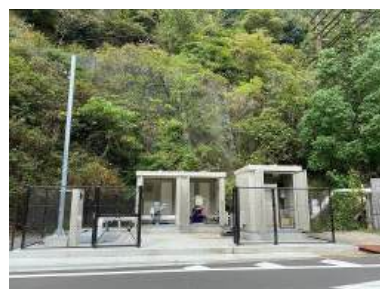
生野マイクロ水力発電所
