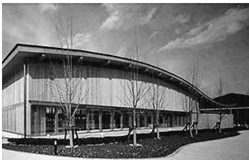
▲市内唯一の屋内プール施設「くじら」
