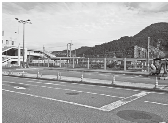
▲工事中の和田山駅前ロータリー
