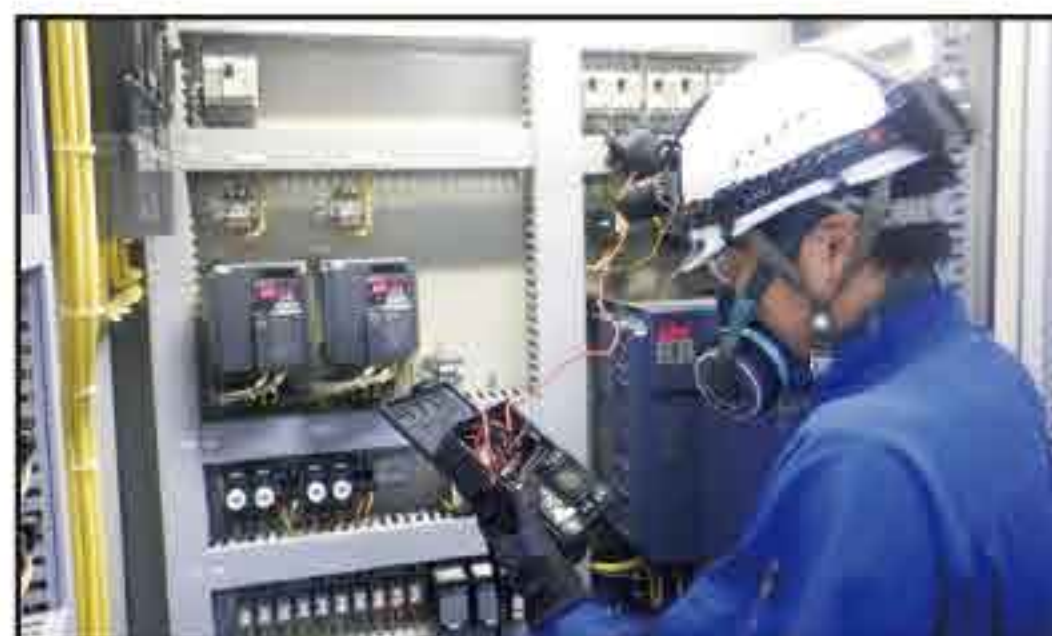
現場点検・パトロール中です。
