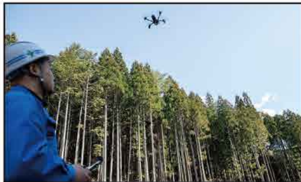
ドローンによる現場撮影
