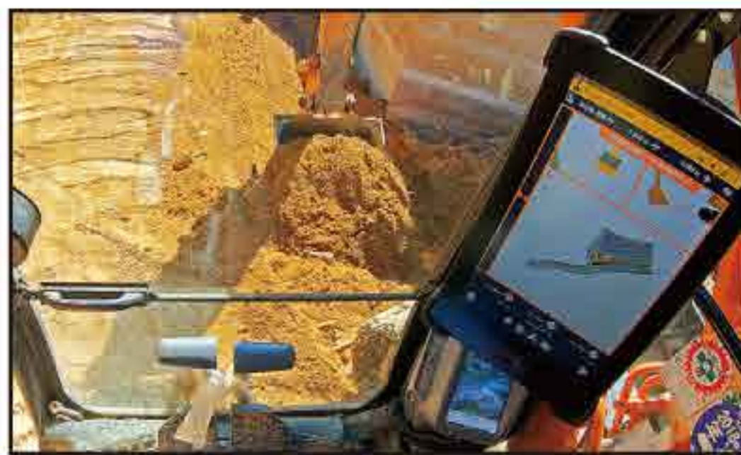
マシンガイダンスによる掘削
