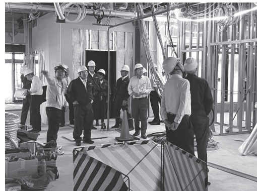
▲現在工事中の新生野庁舎本館
