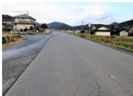
センターライン等の修繕
