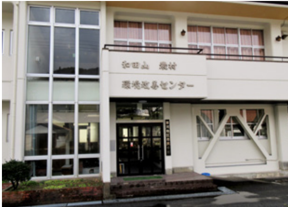
東河地区市民会館
