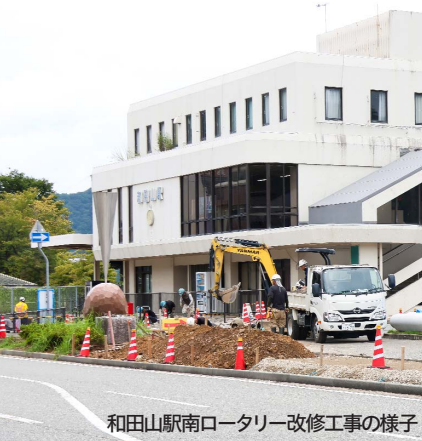
和田山駅南ロータリー改修工事の様子
