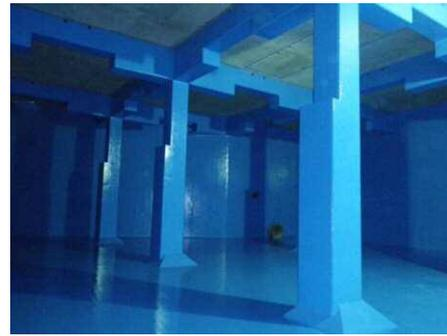
補強後：柱を太く梁を補強
