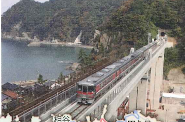
② 新余部橋梁
