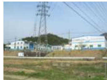
和田山工業団地の工場群
