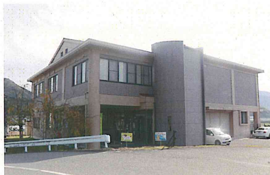
< 防災センター >
