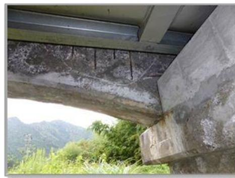
コンクリートが剥離し鉄筋が見えています。
