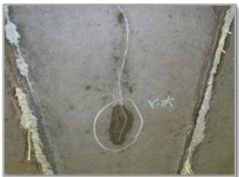
コンクリート桁にひびわれが発生しています。
