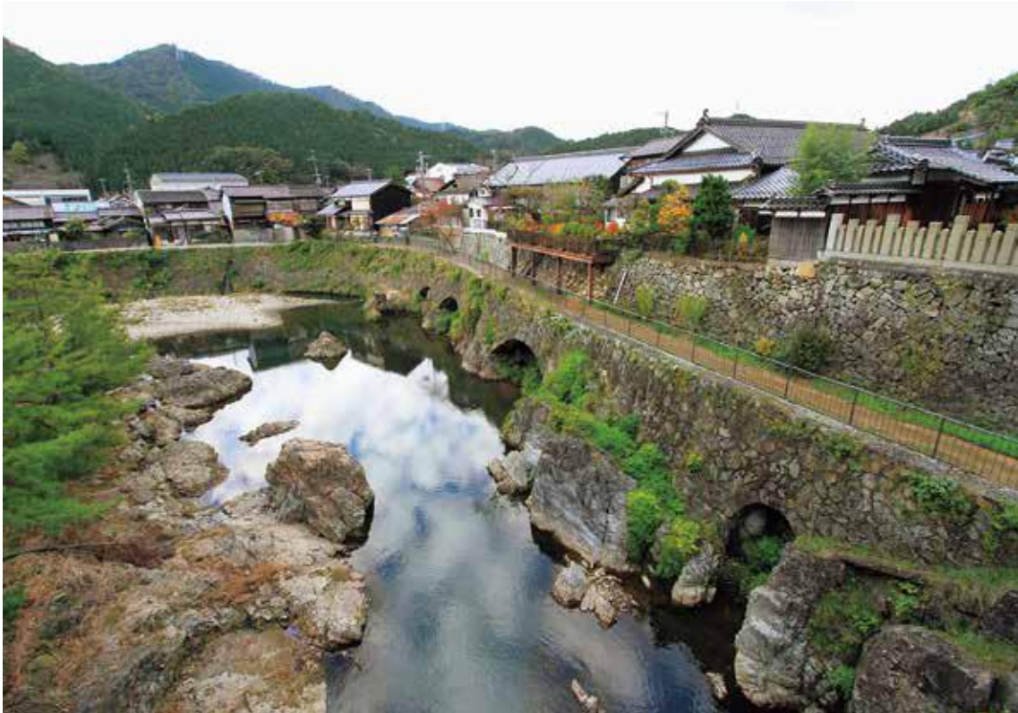
生野鉱山関連遺構（トロッコ道）
