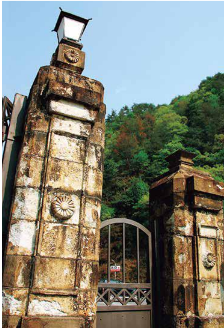
生野鉱山関連遺構（生野鉱山正門門柱）
