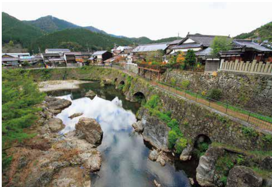
生野鉱山関連遺構（トロッコ道）
