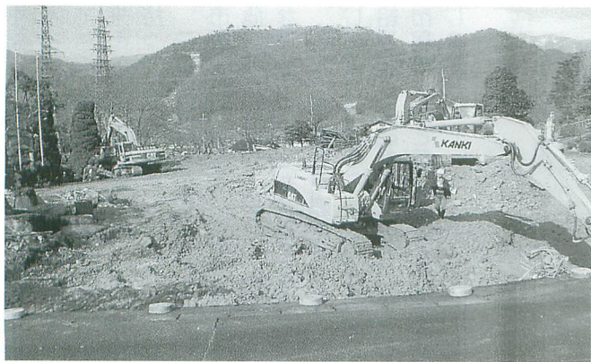
▲解体撤去・整地が進む立雲荘跡地
