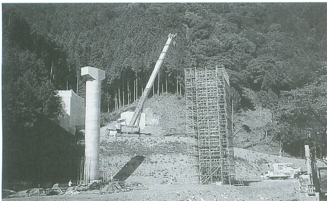
▲ダム建設に伴う県道付け替え工事現場
