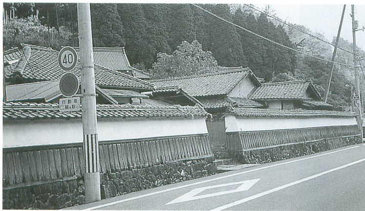
▲保存・展示、公園化等の整備が計画されている甲杜宅付近
