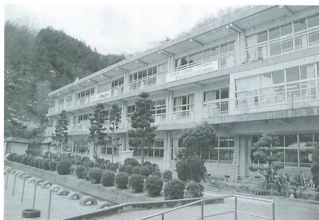
▲耐震・改造工事が行われる枚田小学校
