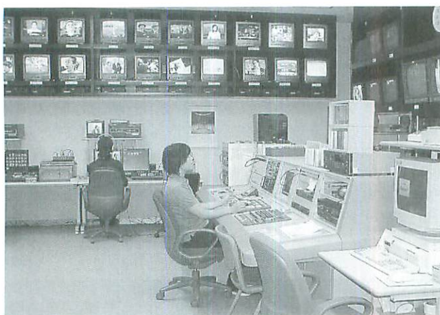
▲デジタル化が進められるケーブルテレビセンター
