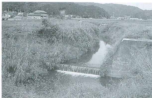
▲東河川で、川幅が狭くなっている箇所
