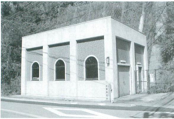
▲廃止される水力発電所
