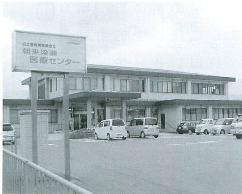
▲朝来梁瀬医療センター
