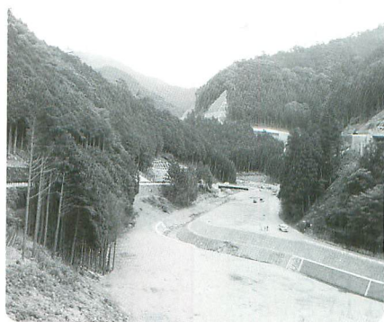
▲与布土ダムの建設現場
