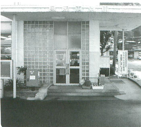
▲点字ブロックの設置が期待される箇所
