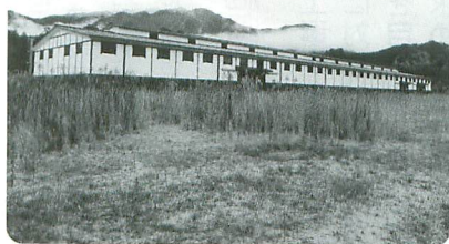
▲地域活性化向け工業団地化を 目指して市が購入した土地 工場
