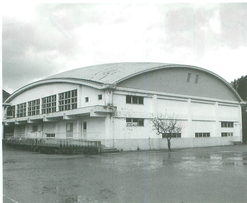
▲改築のため取り壊される和田山中学校屋内運動場
