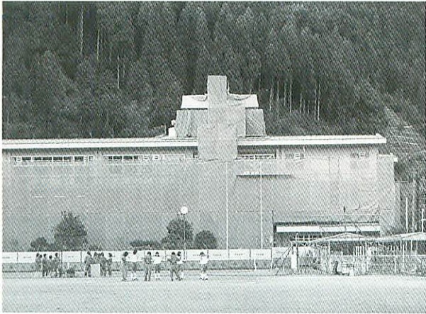
▲校舎の地震補強 工事中の朝来中学校
