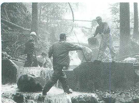
▲豪雨のため土砂で埋まった特設水道施設の復旧作業を急ぐ藤和区民
