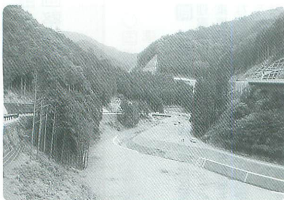
▲工事の早期再開が望まれる与布土ダム
