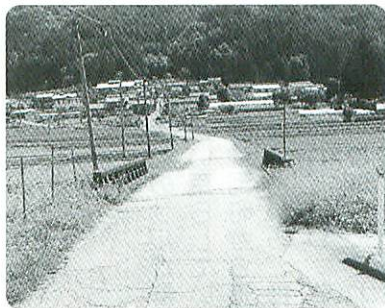
改修が要望されている久田和橋
