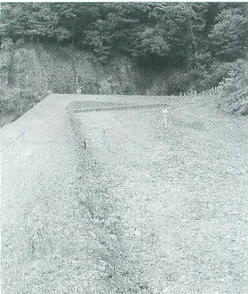
▲舗装改良が行われる林道床尾線 和山町竹ノ内と豊岡市但東町とを結ぶ 基幹林道です。今回の舗装改良は、延長 3,492mについて実施されます。
