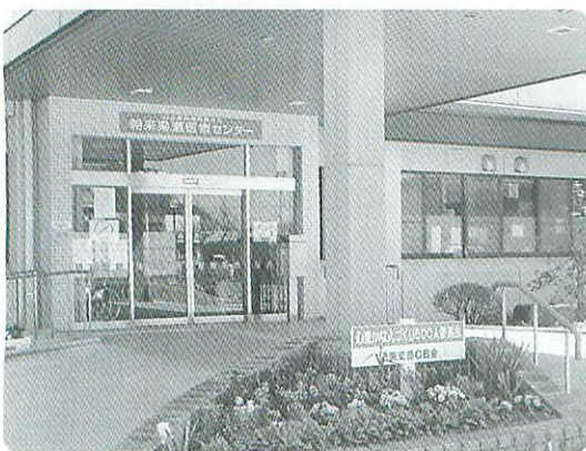
▲朝来梁瀬医療センター
