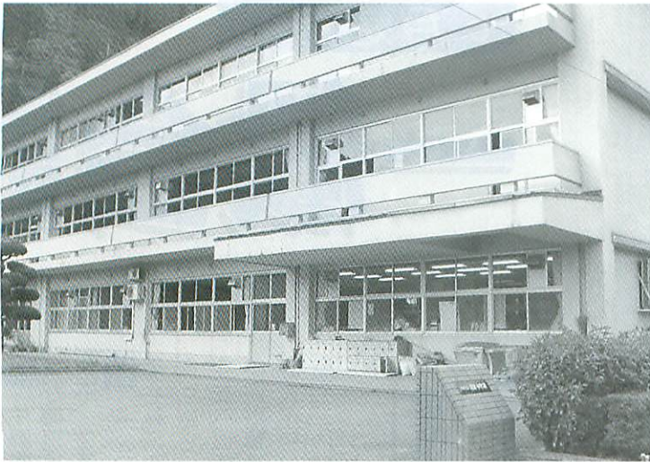
▲校舎の地震補強工事が実施される朝来中学校（新井）。夏休み中に工事予定ですが、安全面に十分配慮を。
