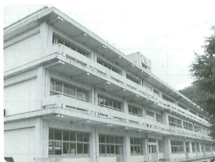
▲地震補強のため大規模改造される和田山中学校校舎
