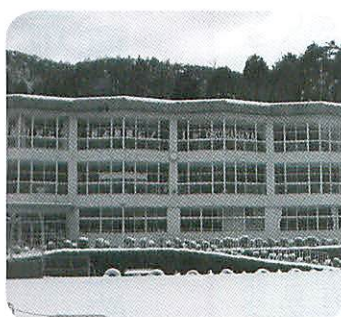
▲旧奥銀谷小学校舎 早急な利活用が求められる
