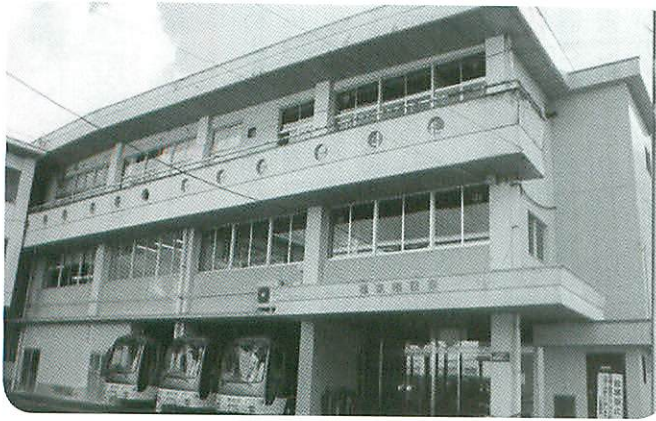
▲一部耐震不足の農業研修センター
