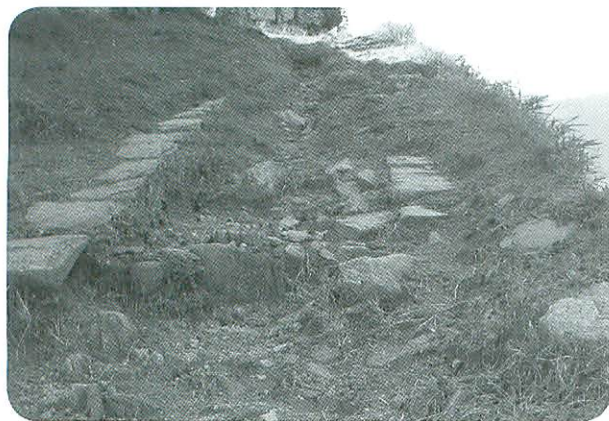
▲天守台に至る通路 荒れが激しい（竹田城跡）
