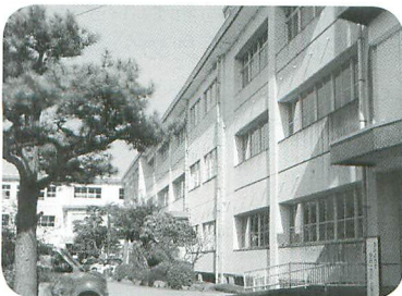
▲地震補強工事が予定されている大蔵小学校
