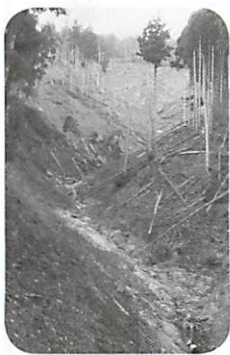
崩落した法面 （与布土ダム周辺）
