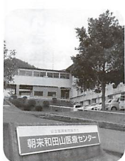
老朽化による改築が計画されている和田山医療センター
