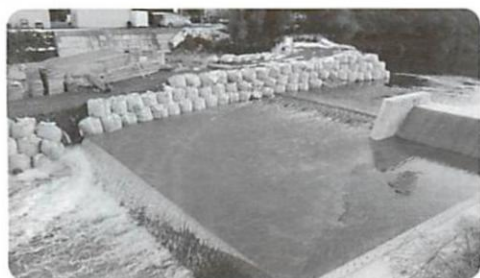
工事が進む向田井堰 (多々良木の円山川河川敷で)
