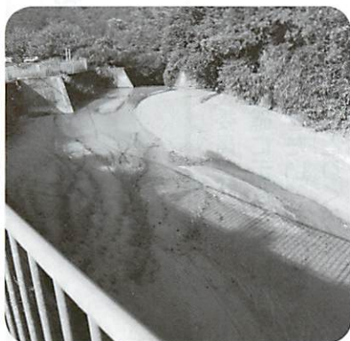
土砂で埋まった深谷川の沈砂地(宮田)
