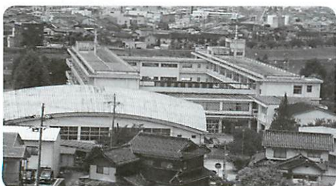
▲改築・地震補強大規模改造が行われる 和田山中学校
