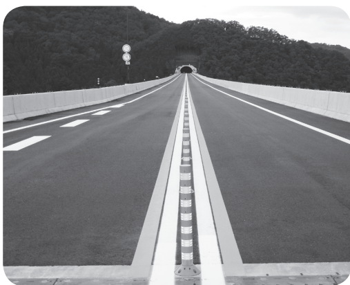
▲延伸の影響が心配される北近畿豊岡自動車道
