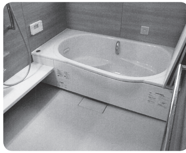
▲改修された浴室
