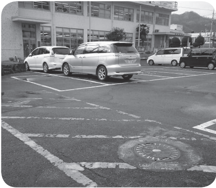
▲水位が低下をしている市役所前の防火水槽
