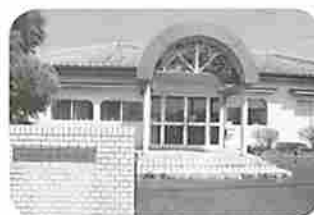
▲改修され栗鹿自治協の拠点となる旧栗鹿幼稚園
