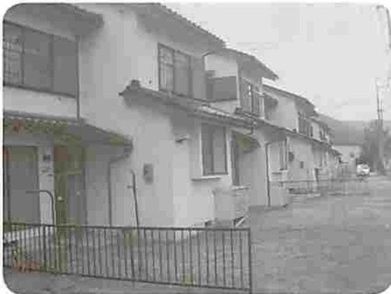
▲改修を行う市営住宅(加古団地)
