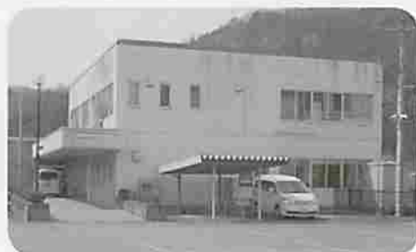
▲老朽化し移転・新築する保健センター(立ノ原)
