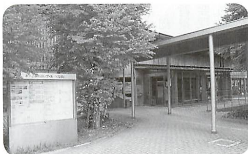
▲温水プール「くじら」
