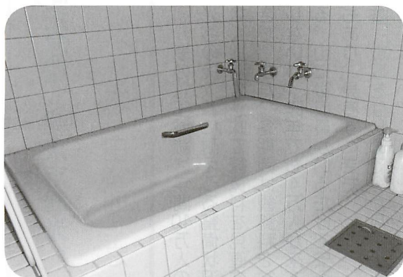
▲住宅リフォーム制度を活用して改修された浴室
