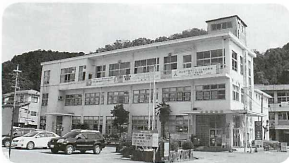
▲取り壊される本庁舎
