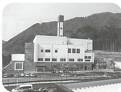
▲乾式バイオマス方式を採用した南但クリーンセンター
