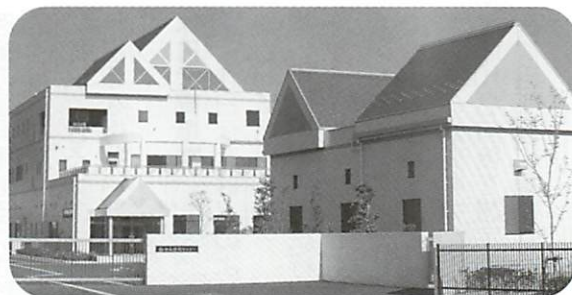
▲企業会計制度の導入に向けた調査を実施（写真は和田山クリーンセンター）
