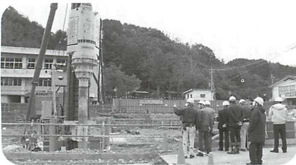
▲新庁舎を支える基礎工事
